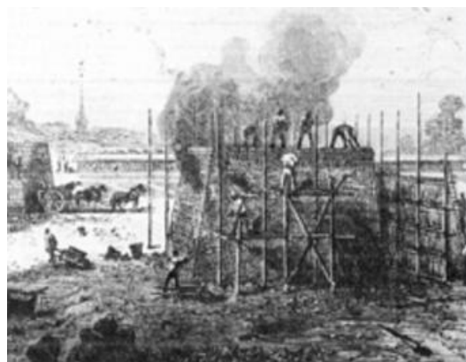
Figura 45: Tijolos secos e sendo moldados à esquerda, com a presença de uma fábrica de queima no fundo; à direita a queima de tijolos entre empilhamento de pedras, forno.
