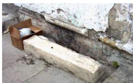
Figura 56: Cantaria lateral exposta da UD 06
