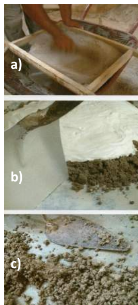
Figura 3: Processo de fabricação da argamassa a cal em Barreiros, PE. (a) peneiração da areia; (b) adição de água sobre a cal e a areia; (c) homogeneização da pasta argamassada.
