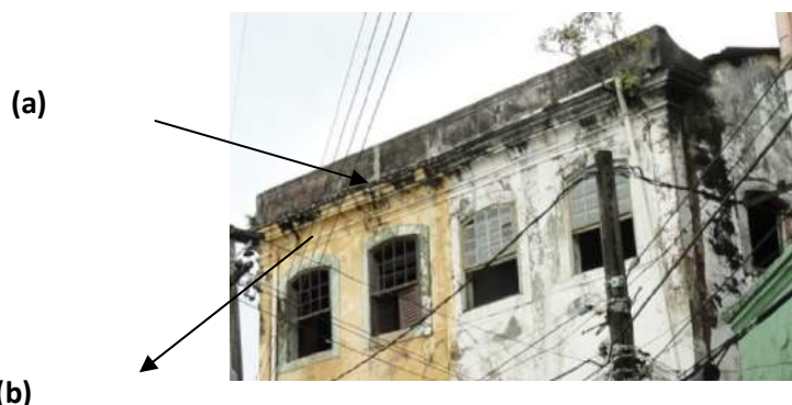
Figura 38: Detalhe das janelas das unidades 03 e 04; (a) Sanca; (b) Platibanda
