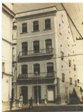
Figura 22: Residência de Joaquim Nabuco na Boa Vista em 1968. Rua da Imperatriz, Nº 147.
