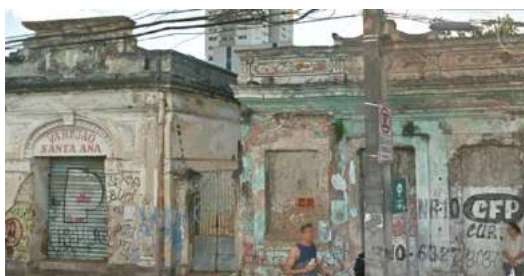
Figura 54: Fachada das unidades 06 e 07
