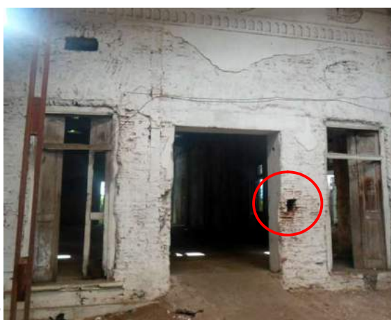
Figura 31: Fachada traseira da UD 01. Detalhe de portas almofadadas. Em vermelho, área de coleta.
